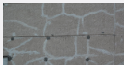
ผนังอาคาร
